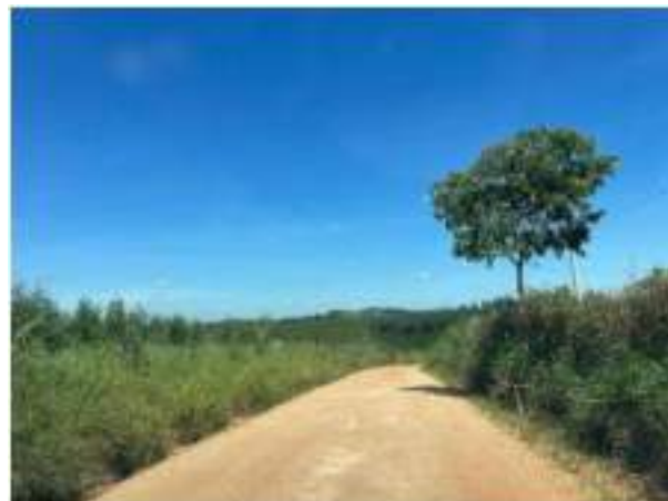
Foto 20 – Estrada de terra monitorada. (Data: 10/02/2023).
