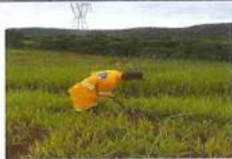
Foto 02 Colaborador realizando atividade de roçada no subleito em referência (registro fotográfico 16/03/2023).
