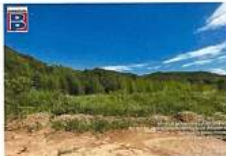
2.2 - vista geral da area
