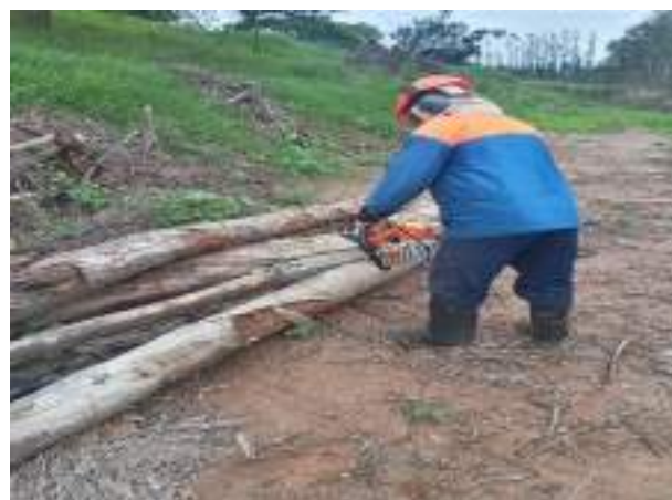
Foto 10 – Parcela 10.3 supressão realizada (Registro fotográfico 13/03/2023).
