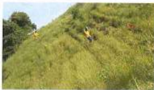
Foto 02 Colaborador realizando manutenção (registro fotográfico 10/03/2023).
