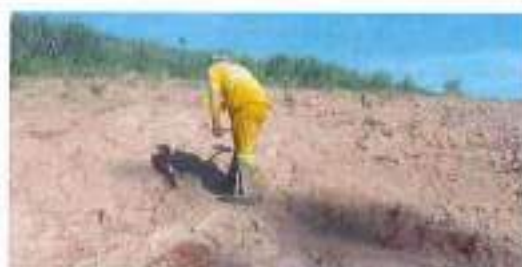
Foto 02 Detalhe da abertura de covas (registro fotográfico 18/03/2023).
