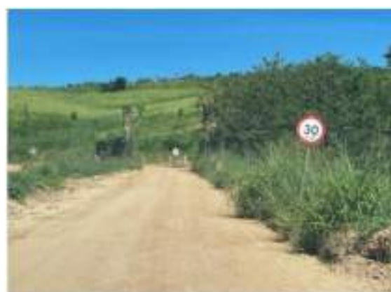
Foto 38 – Implantação de placa de sinalização de velocidade. (Data: 18/03/2023).
