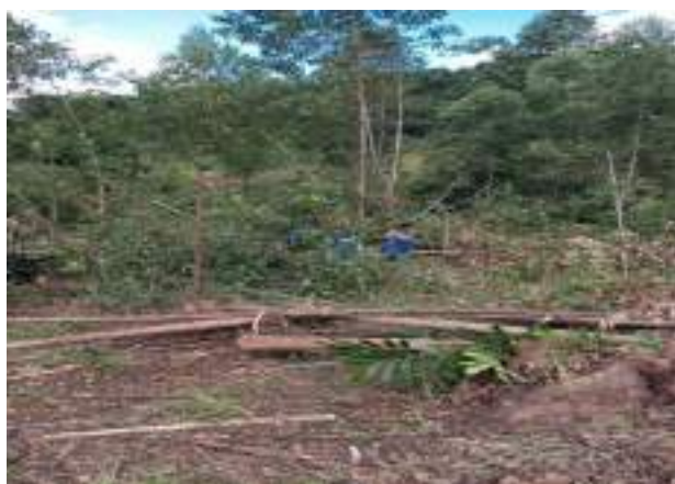
Foto 5 – Colaborador realizando supressão na parcela 46 (Registro fotográfico 10/03/2023).
